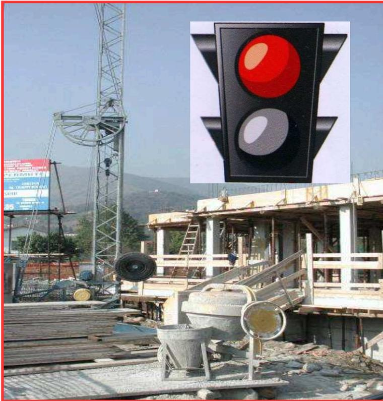
Solido impalcato a protezione del lavoratore addetto alla betoniera sotto il raggio di azione della gru
